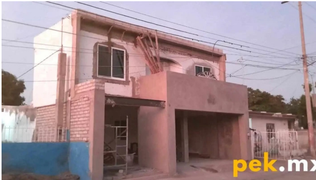
Trabajos en general el manchas lic benito juarez
