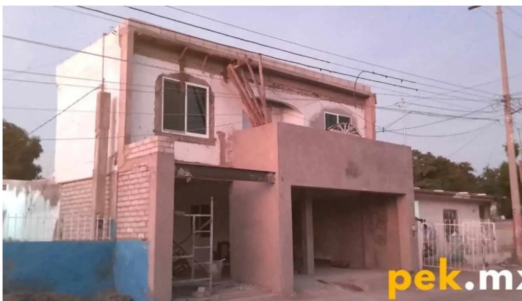
Trabajos en general el manchas abierto ahora
