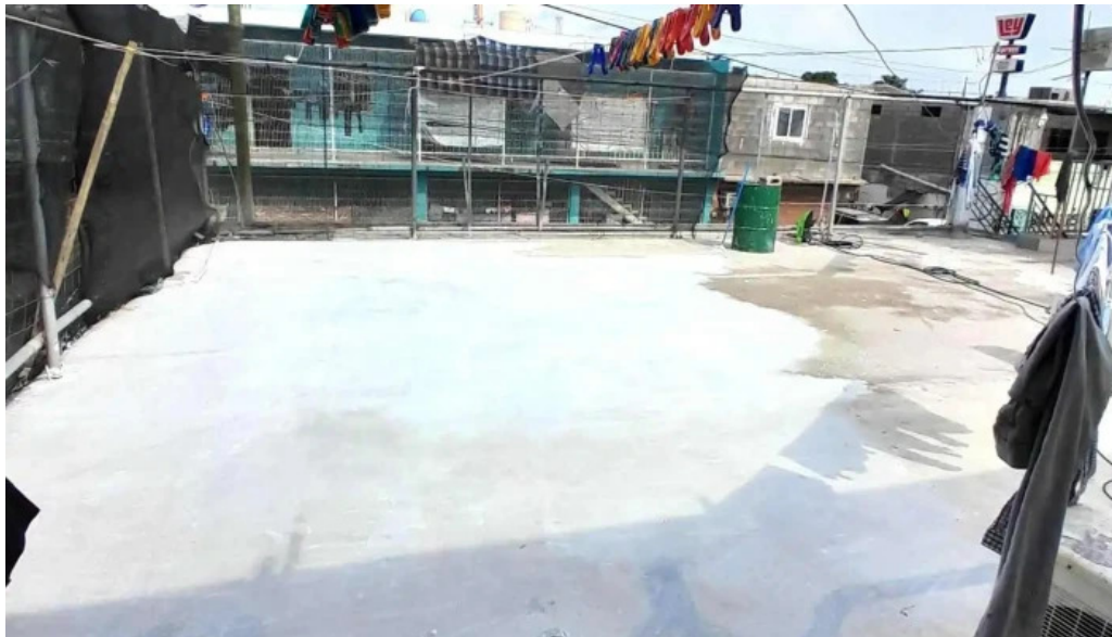
Trabajos en general el manchas del propietario
