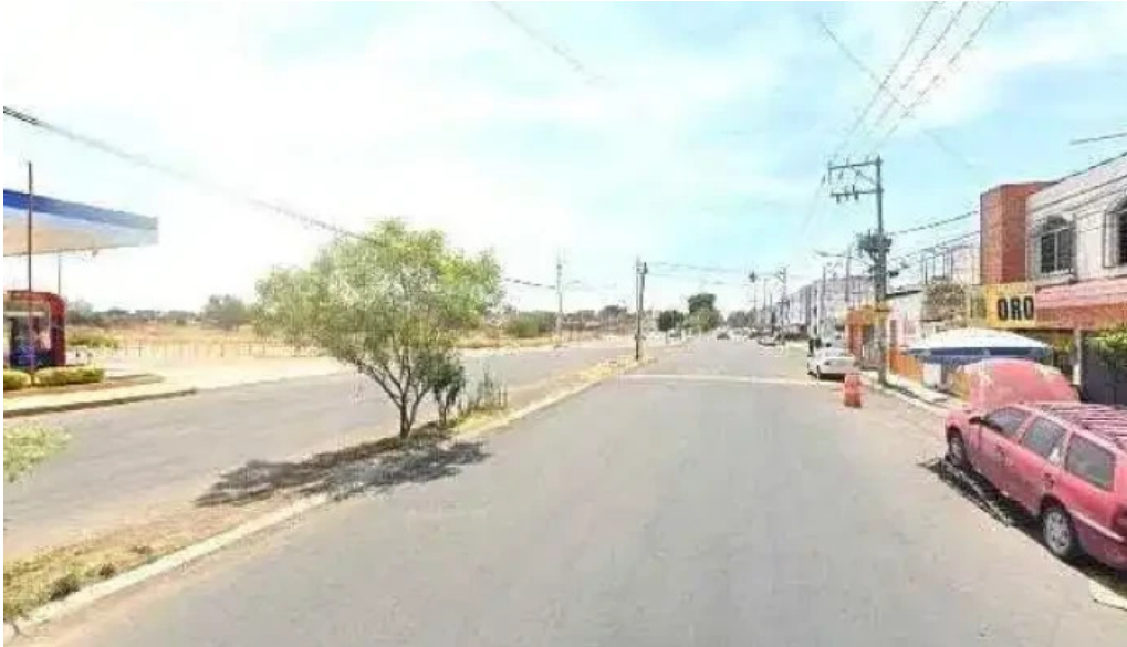
Cerrajería gomez salas telefonodeg
