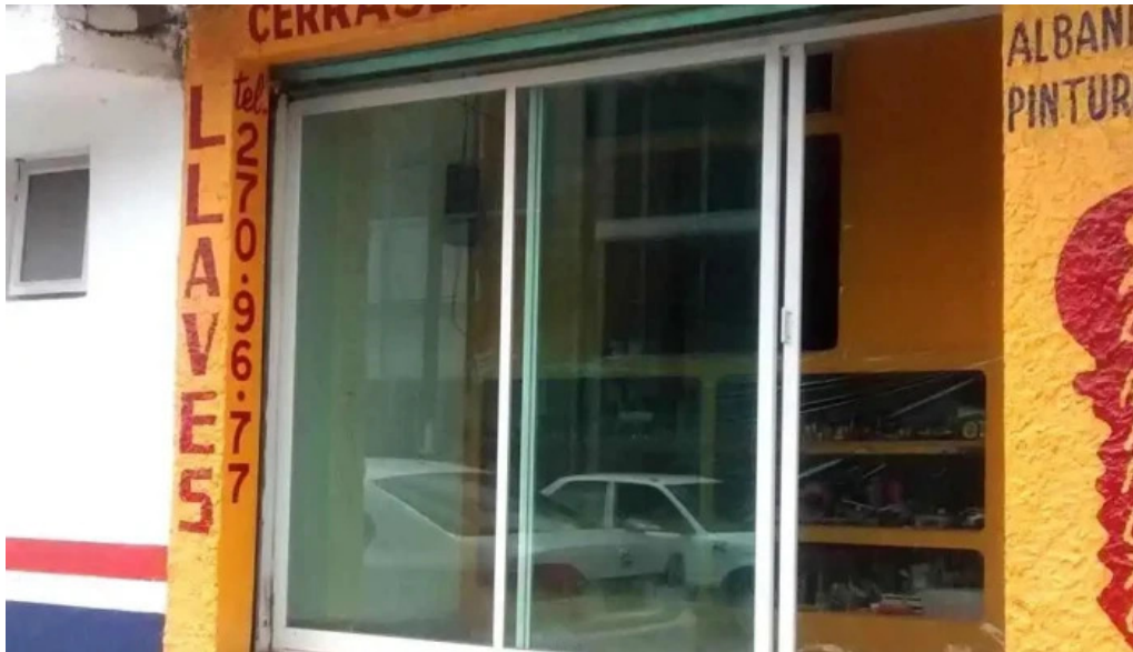
Cerrajería paredes exterior
