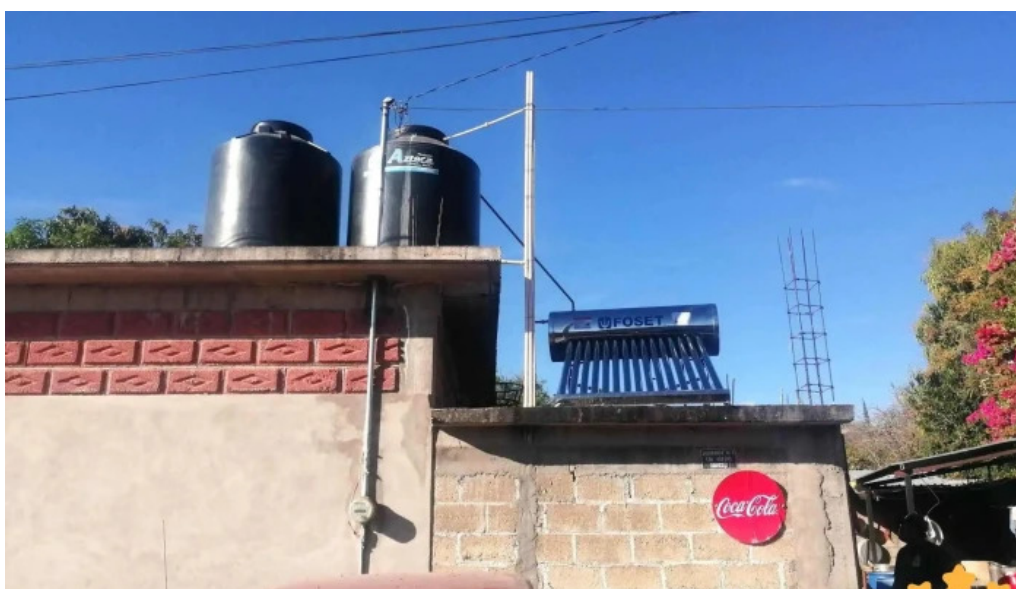
Trabajos de plomeria y electricidad el plomex del propietario
