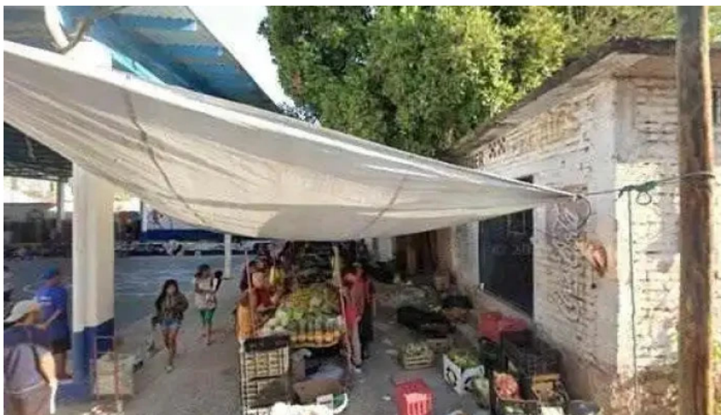
Trabajos de plomeria y electricidad el plomex comentariosdeg
