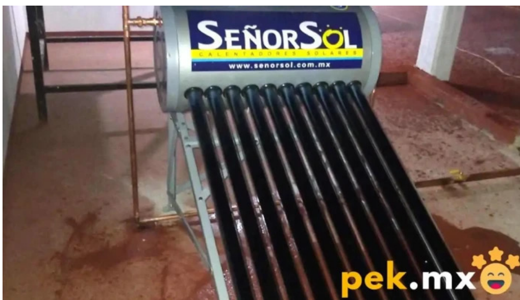
Trabajos de plomeria y electricidad el plomex comentarios
