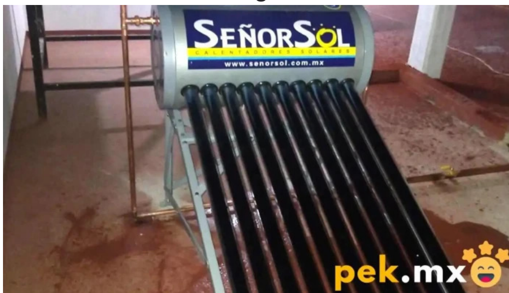
Trabajos de plomería y electricidad el plomex mayanalan
