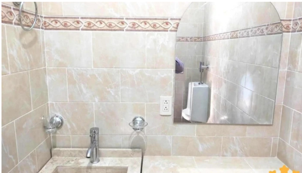
Trabajos de plomería y electricidad el plomex interior
