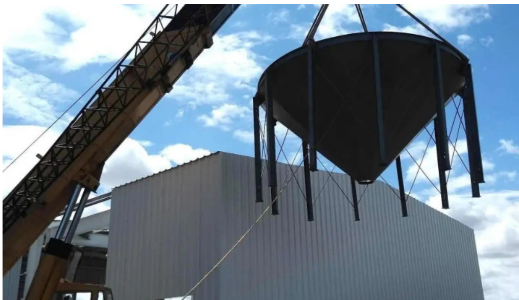
Construcción y mantenimiento industrial hormigón
