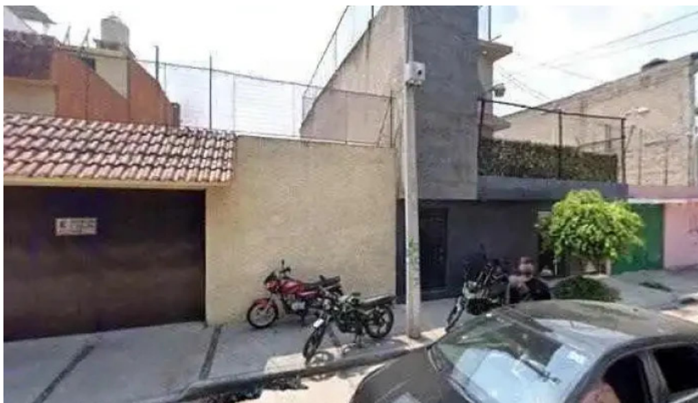
Mantenimiento y suministros electricos como llegardeg
