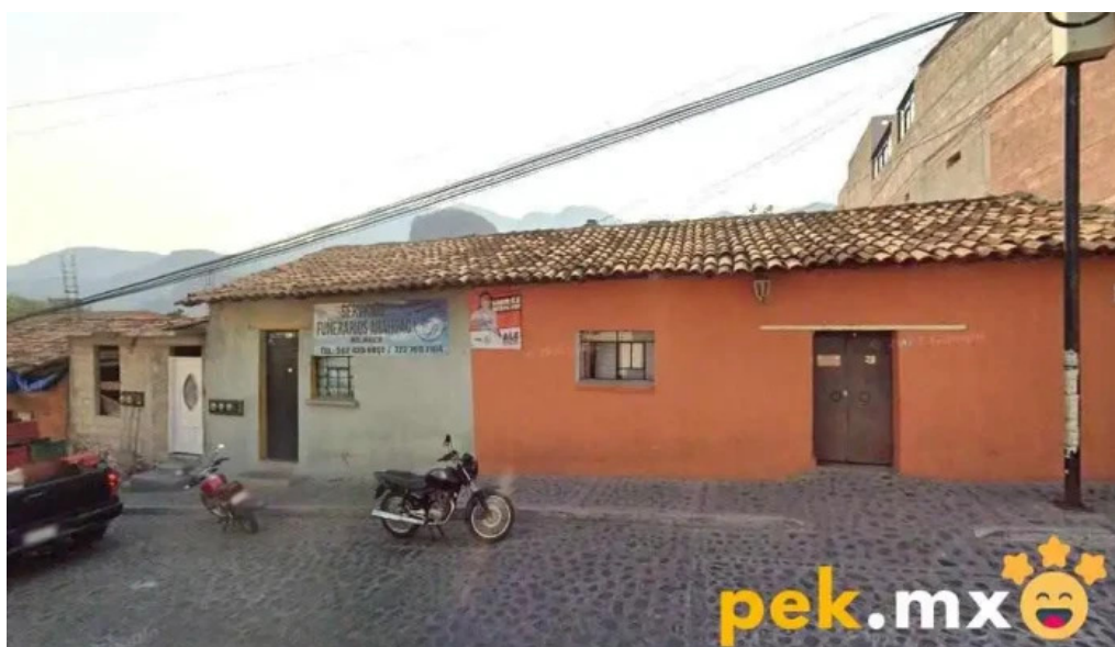
Instalaciones electricas y mantenimiento residencial zarco malinalco
