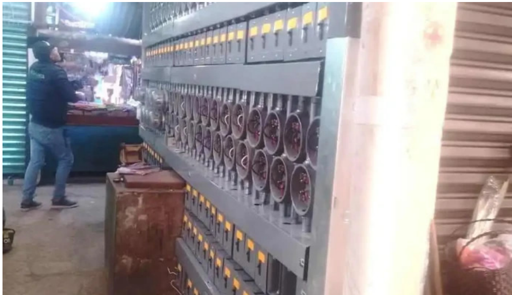
Servicios de electricidad residencial e industrial interior
