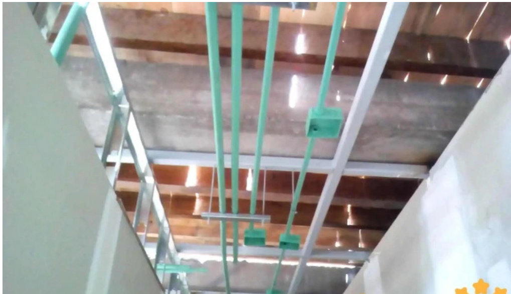
Control electric ubicacion
