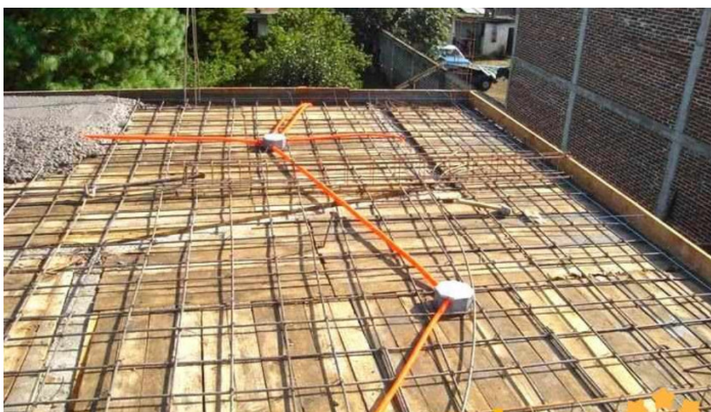
Electrificación rural y servicios atacomulco de fabela
