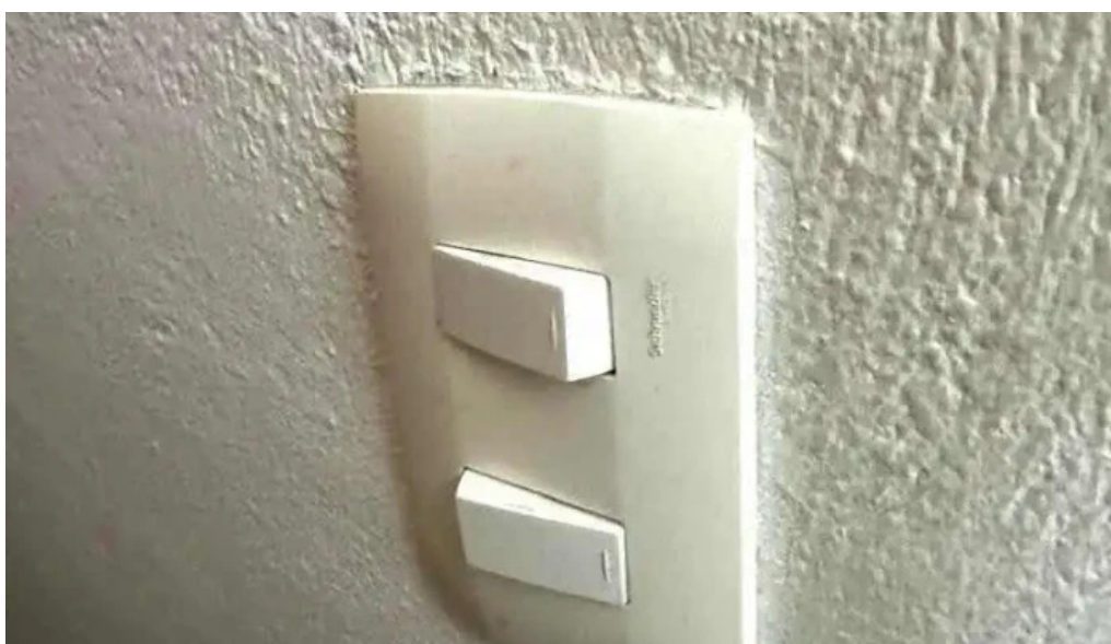
Electricistas a domicilio benito juarez ciudad de mexico
