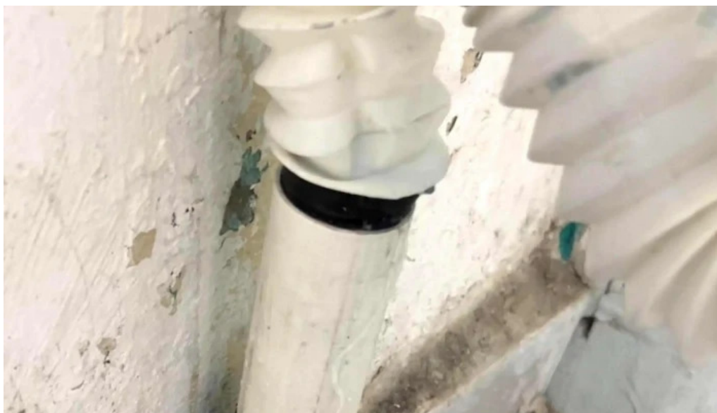
Electricidad herreria plomeria y pintura glez comentarios
