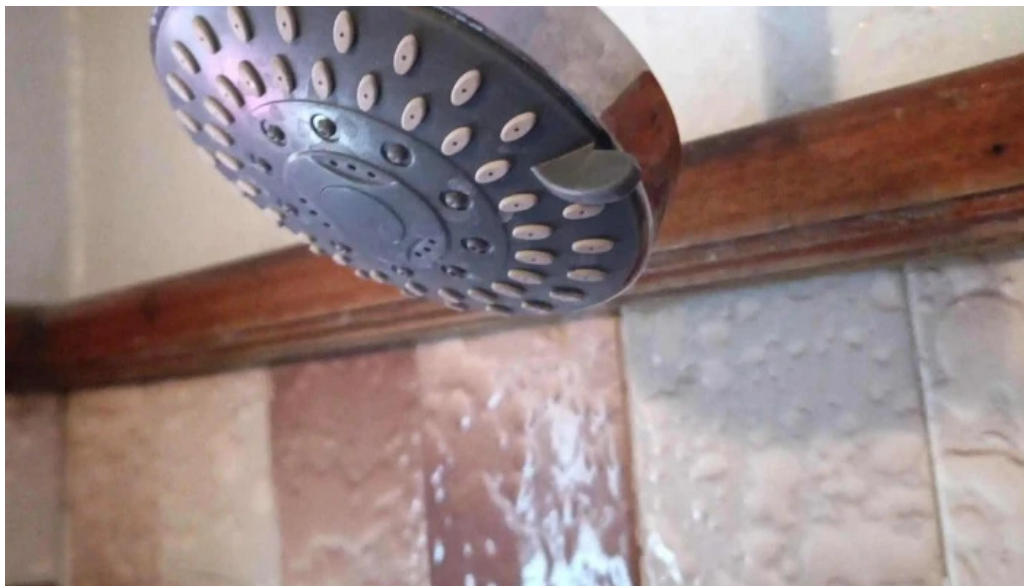
Electricidad herreria plomeria y pintura glez como llegar
