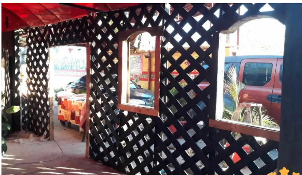
Instalaciones electricas tavar exterior
