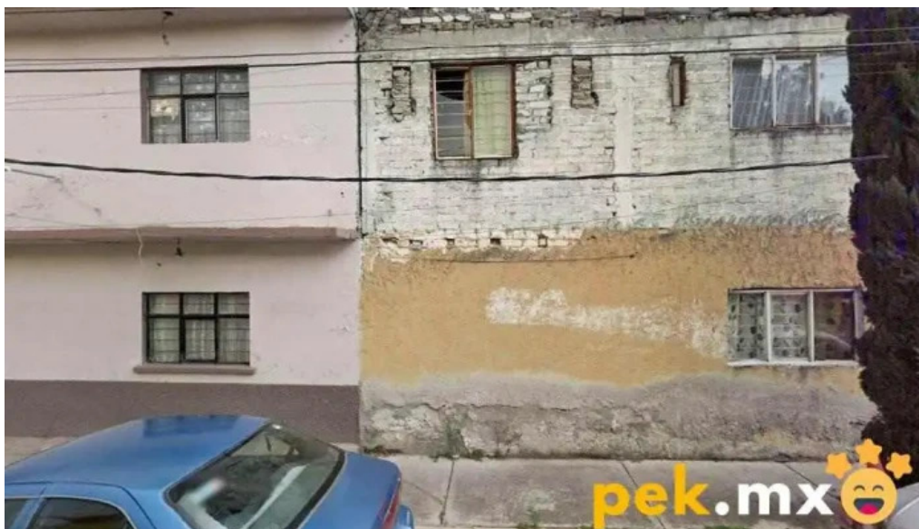
Electricidad y plomeria carmona colin ciudad de mexico
