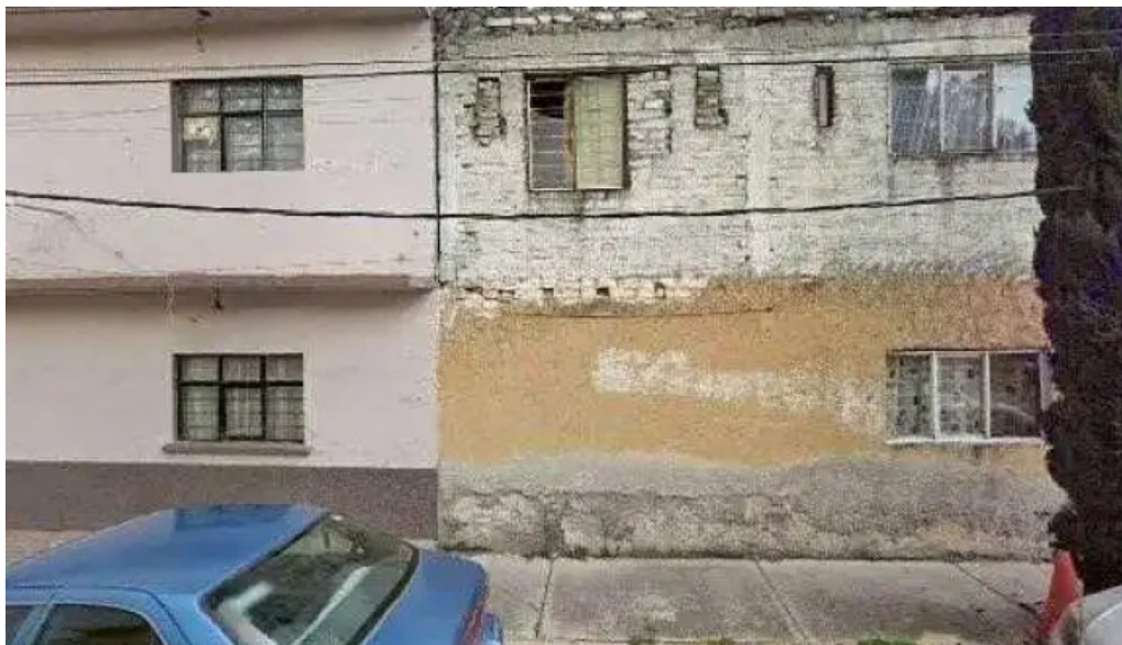
Electricidad y plomeria carmona colin como llegar
