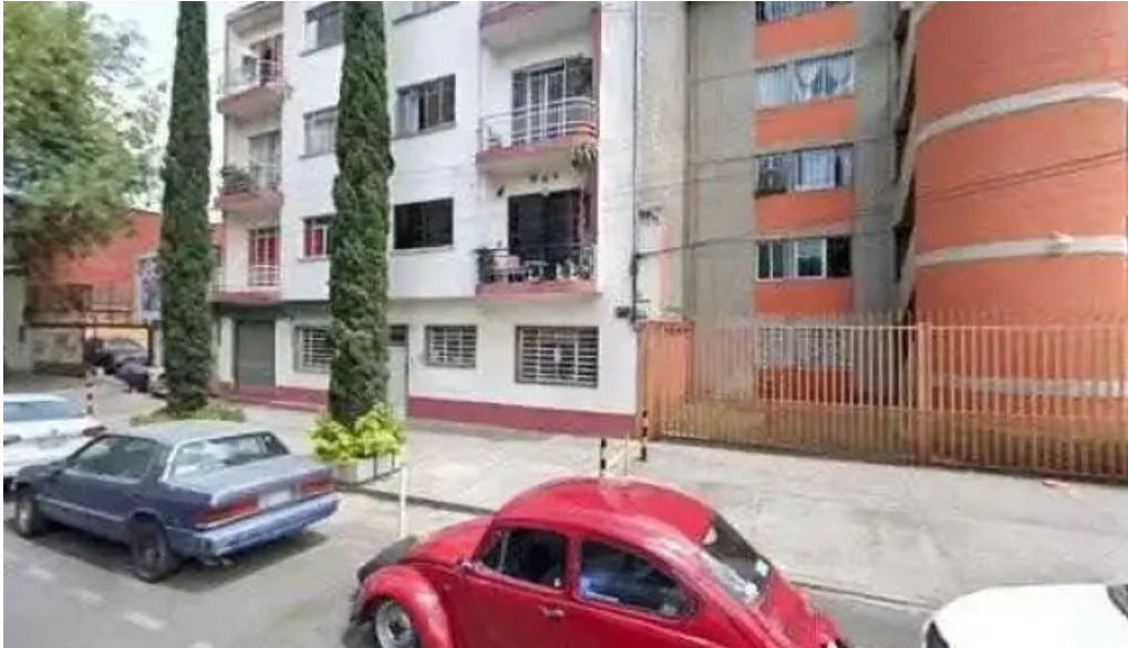
Local de electricidad ubicacion
