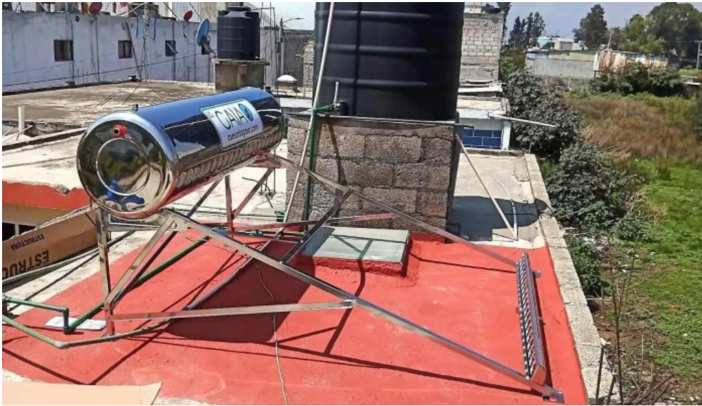
Mantenimiento electricidad fotos
