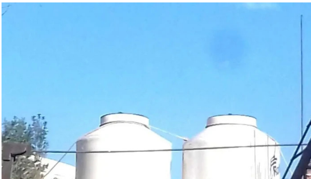
Instalaciones electricas y plomeria direccion
