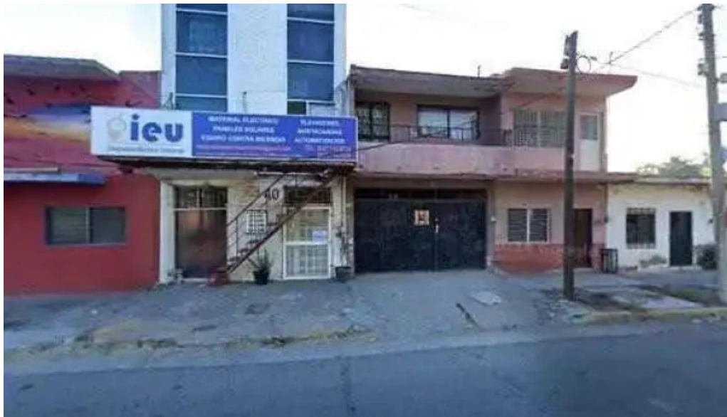
Integradora electrica universal donde
