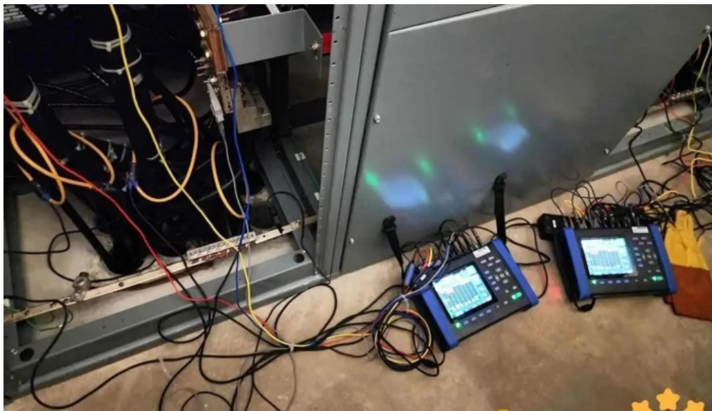
Pr automatizacion y proyectos electricos delicias
