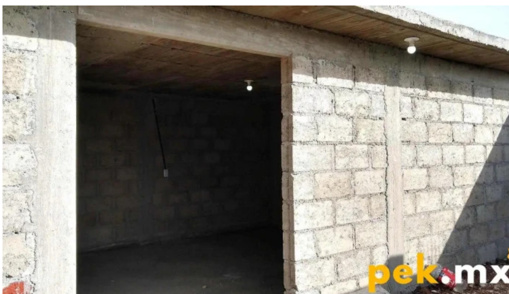
Plomería y electricidad del propietario
