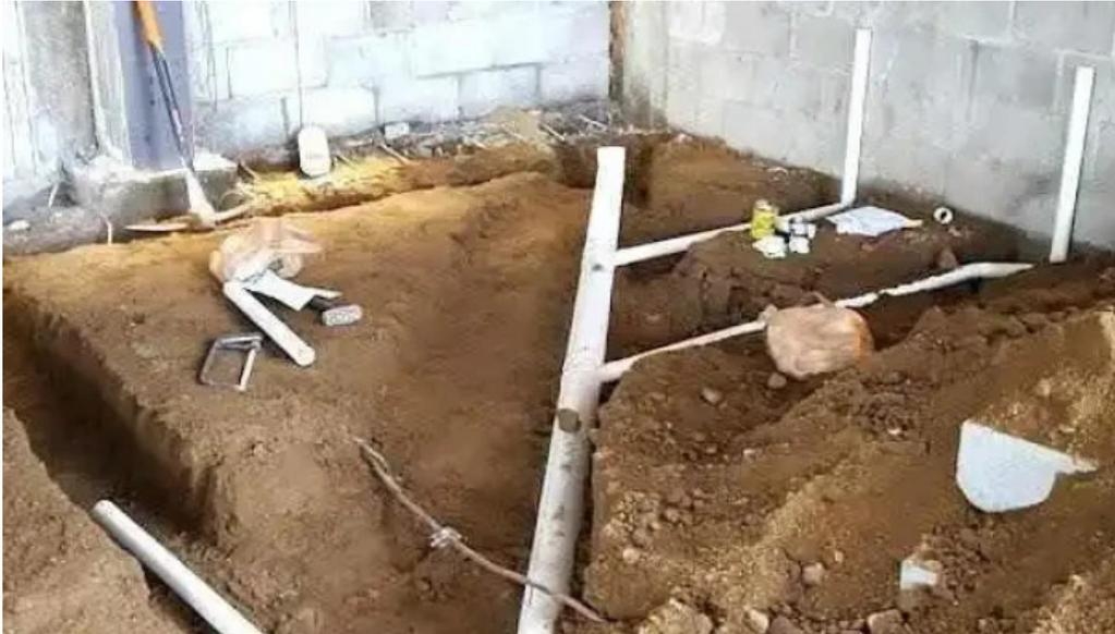
*Instalaciones electricas hidraulicas y sanitarias cardelassammy fraccionamiento hacienda del bosque*
