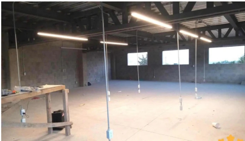
Electricistamantenimiento en general interior
