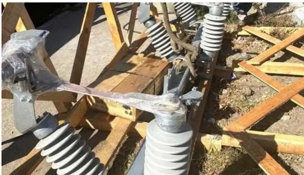
Preyc electricidad telefono
