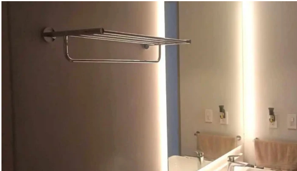
Instalacion electrica y sistemas de seguridad j c martinez 1 interior
