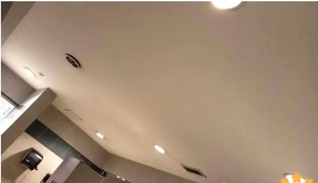
Reparacion y instalacion electrica morelia
