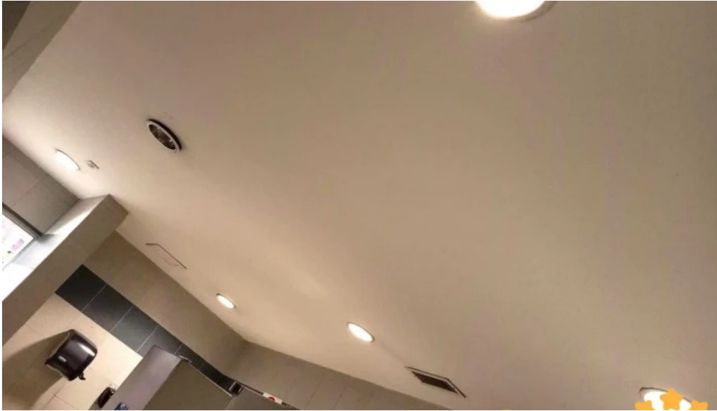
Reparacion y instalacion electrica numero
