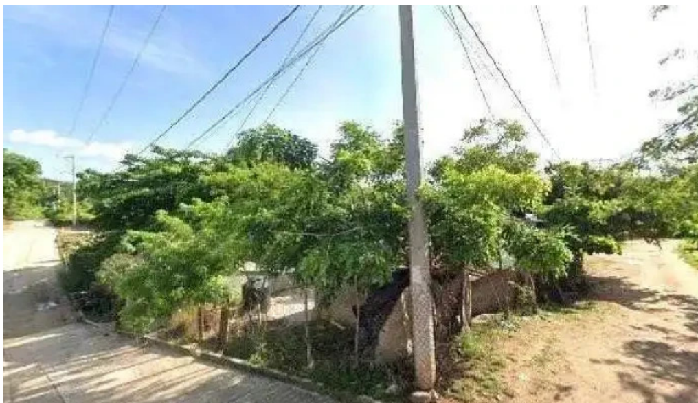
Comision federal de electricidad cfe cerca de mi
