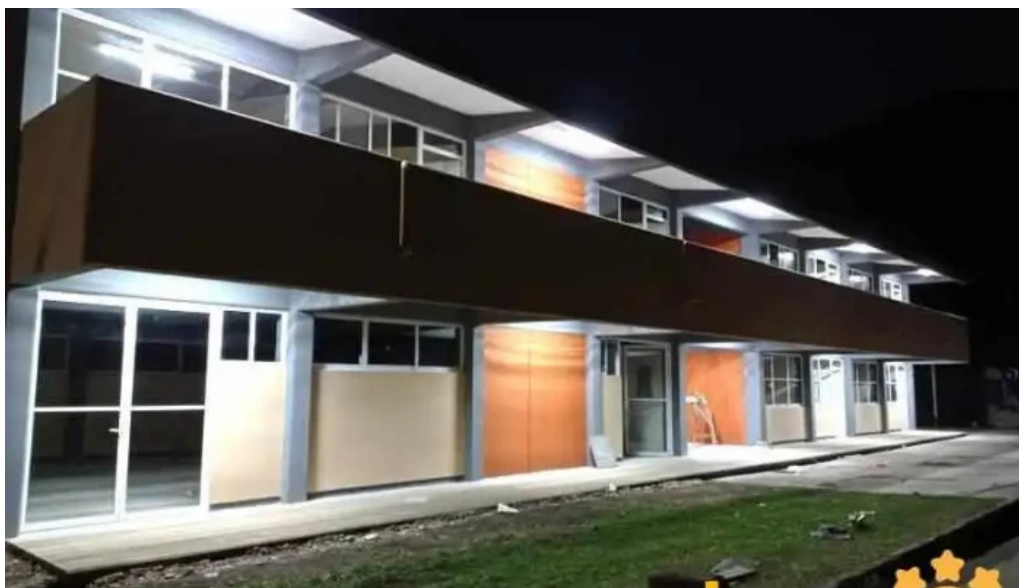
leler instalaciones electricas y mantenimiento orizaba
