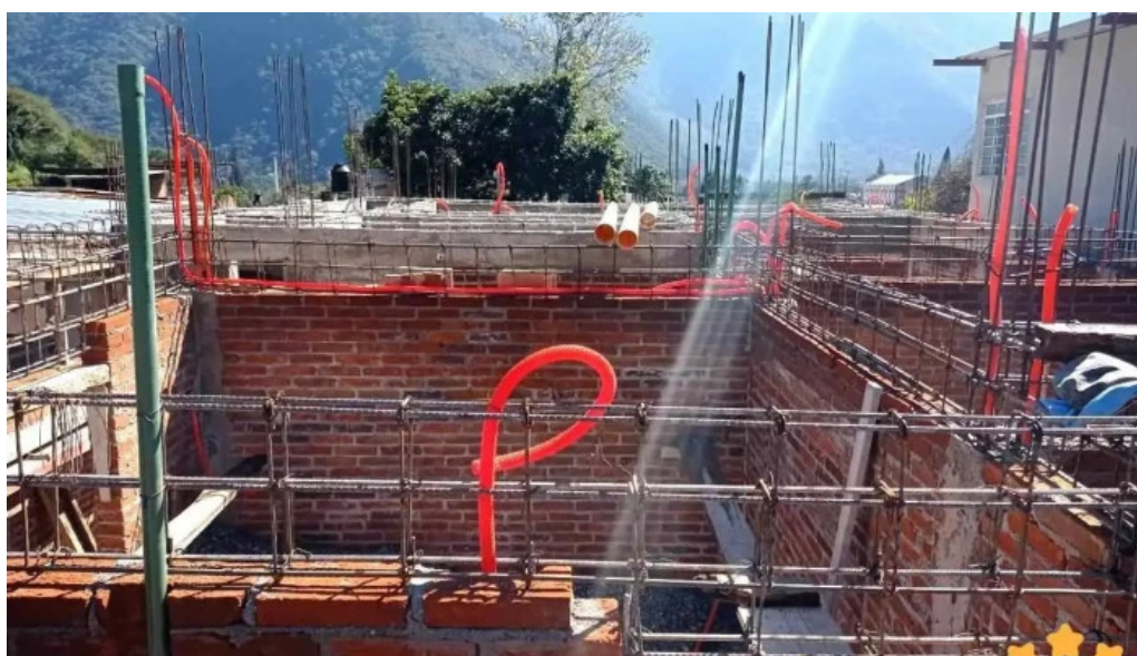
leler instalaciones electricas y mantenimiento del propietario
