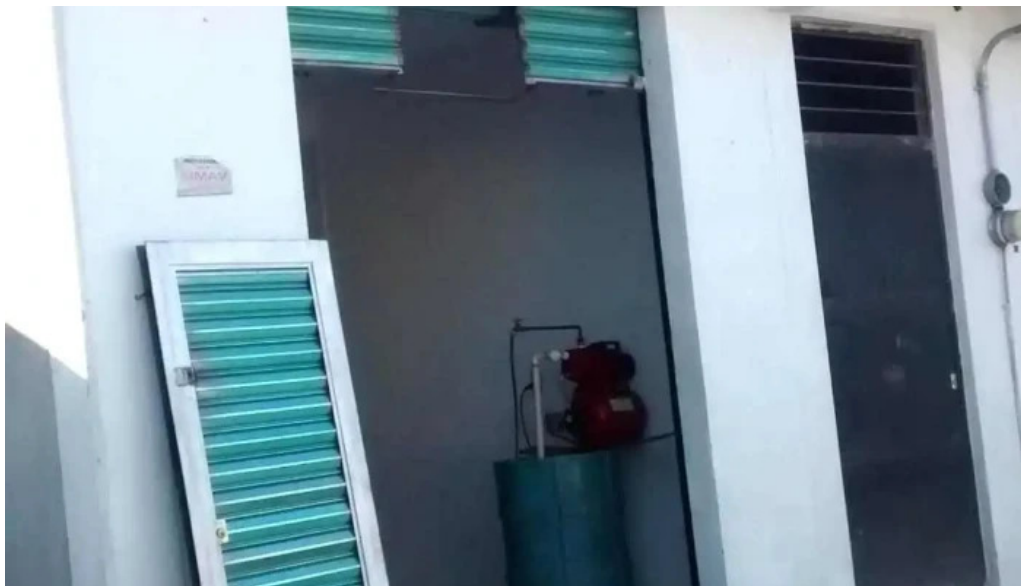
Servicio de plomería y electricidad exterior
