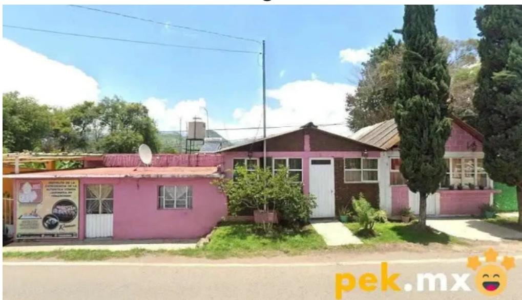
Instalaciones electricas residenciales fernandez san jose teneria
