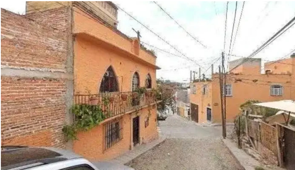
Instalaciones de luz para el hogaretc ubicaciondeg
