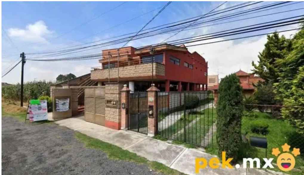
Herreria e instalaciones electricas hernandez san salvador tizatlalli
