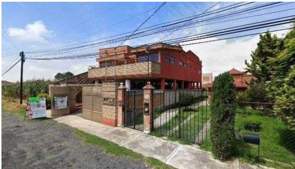
Herreria e instalaciones electricas hernandez opiniones
