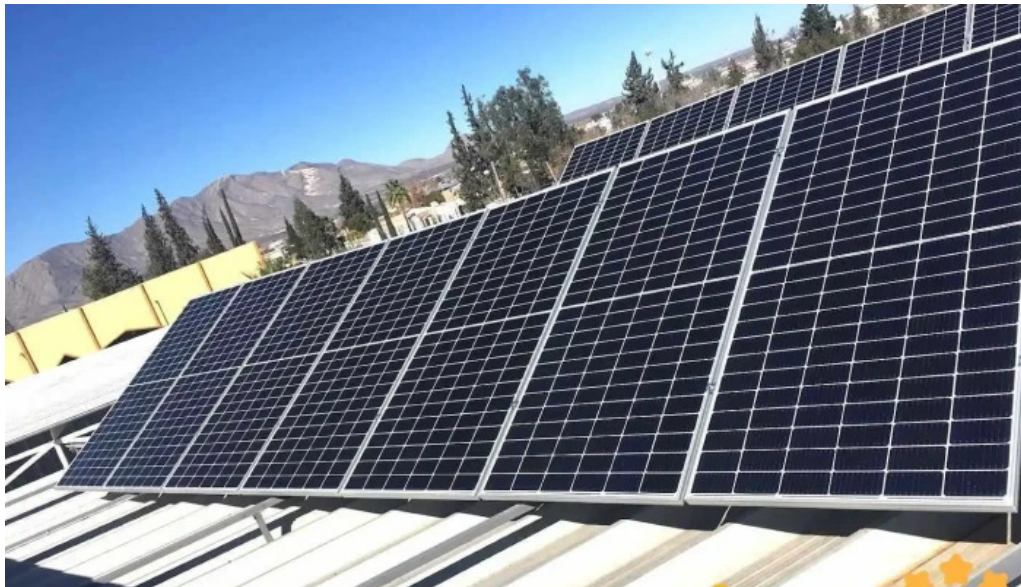
Solar construction santa rosalia de camargo
