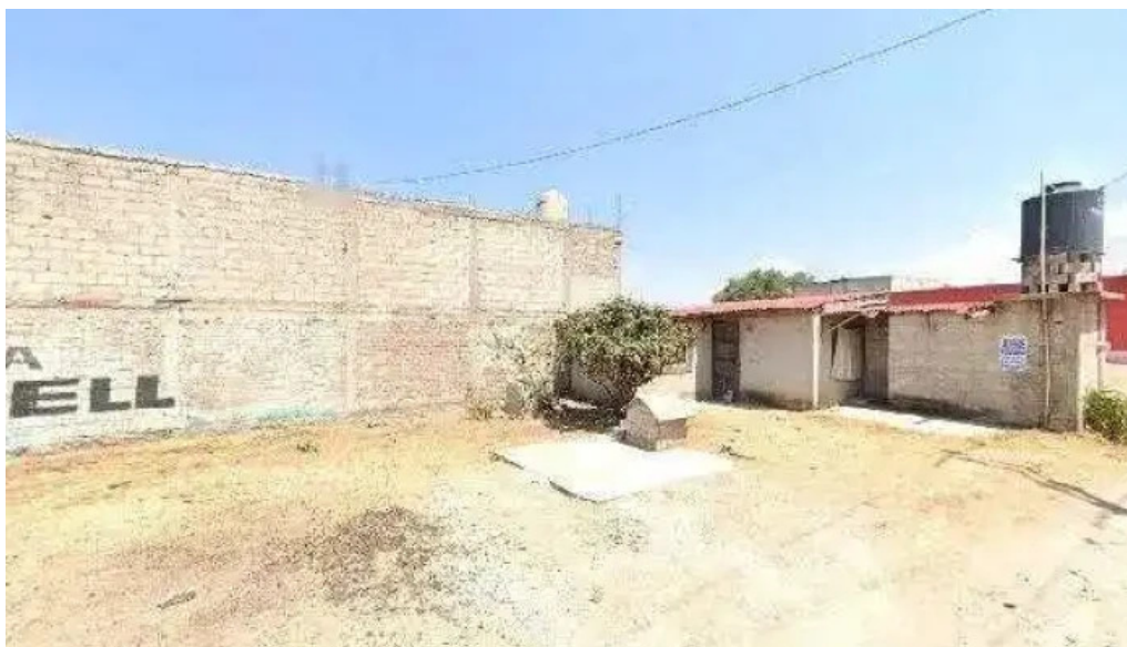
Material electrico los gatos como llegar
