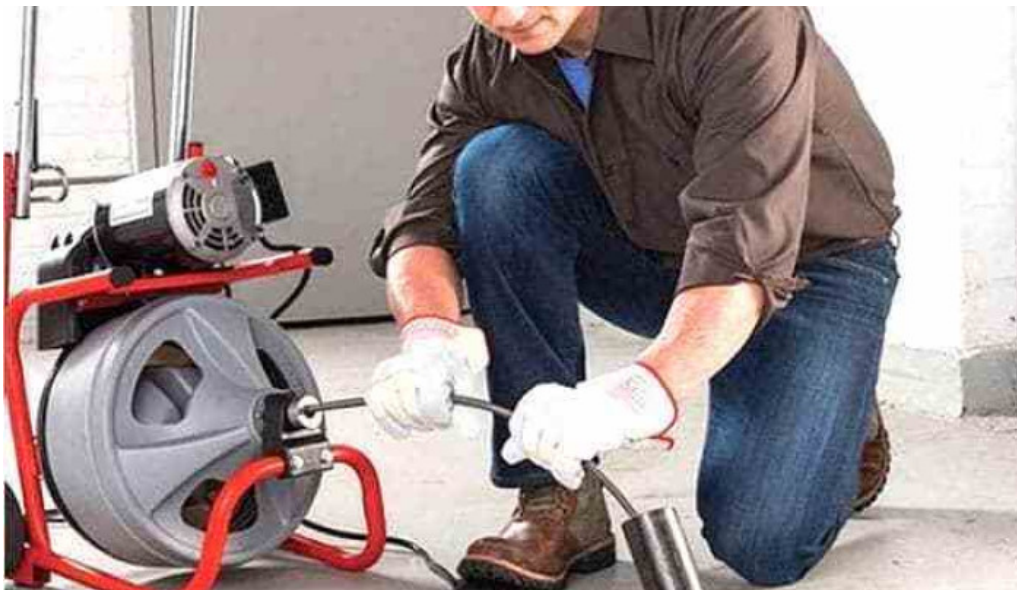
Duran tec electricidad y plomeria tlalpan ciudad de mexico
