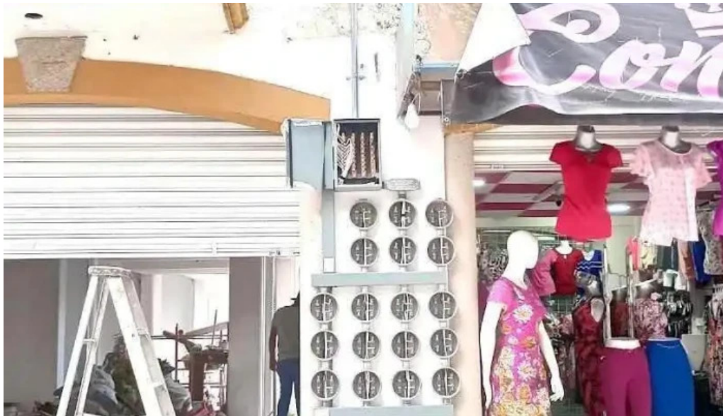
Tec electricista tlapa de comonfort
