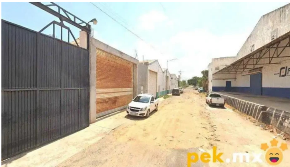
Siec servicios de ingenieria electrica y construccion culiacan rosales
