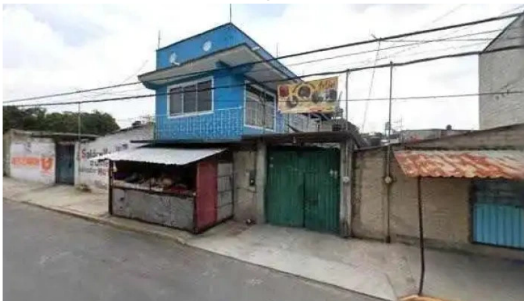
Herreria plomeria y electricidad sitio web
