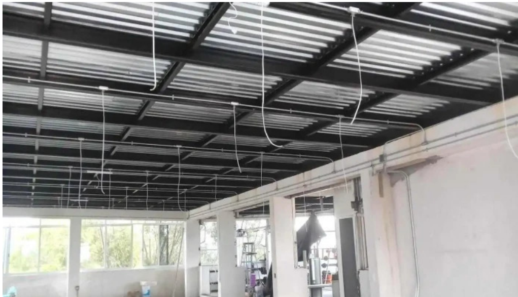
Servicio de plomeria electricidad y albanileria la nacional del propietario
