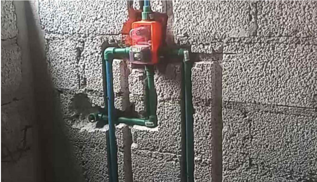
Servicio de plomeria electricidad y albanileria la nacional tuberia
