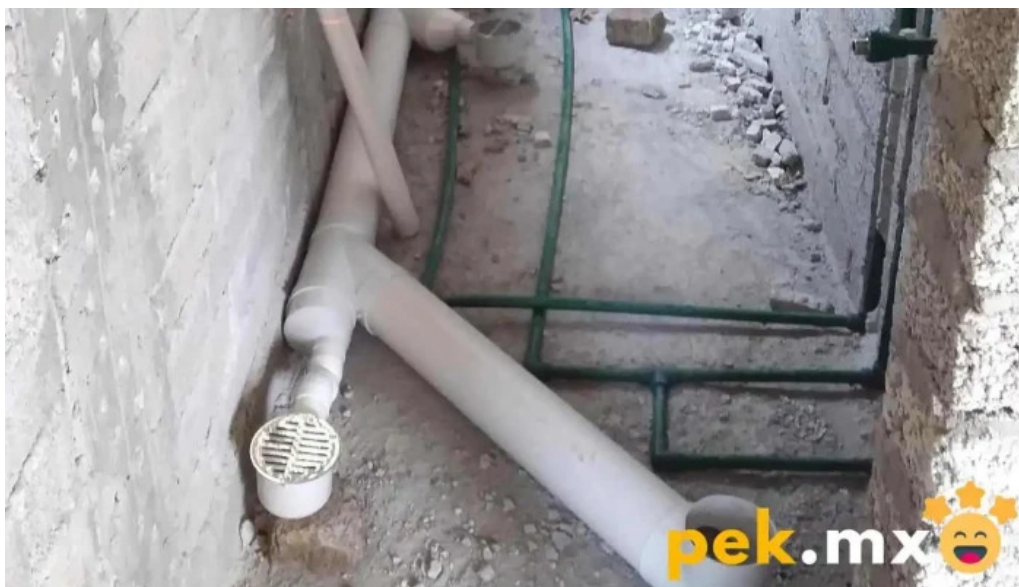
Servicio de plomeria electricidad y albanileria la nacional zona
