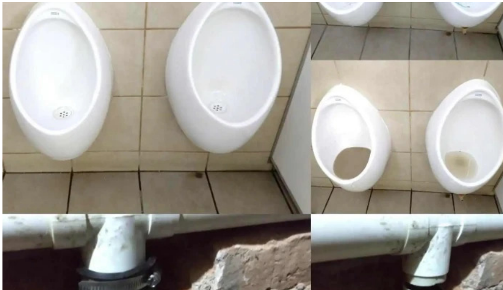
Plomero fontanero electricidad jp interior
