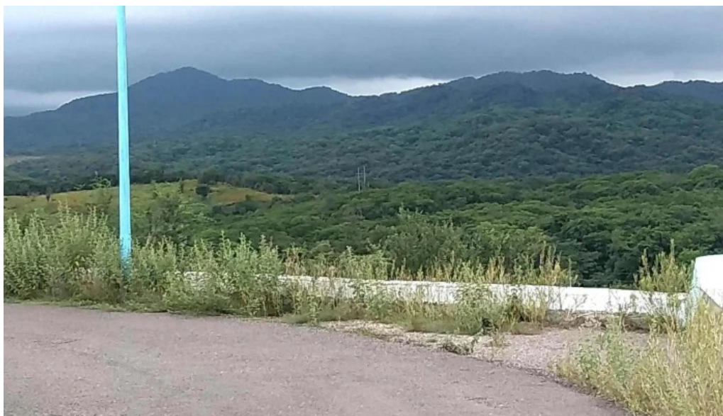
Hidroelectrica sanalona zona
