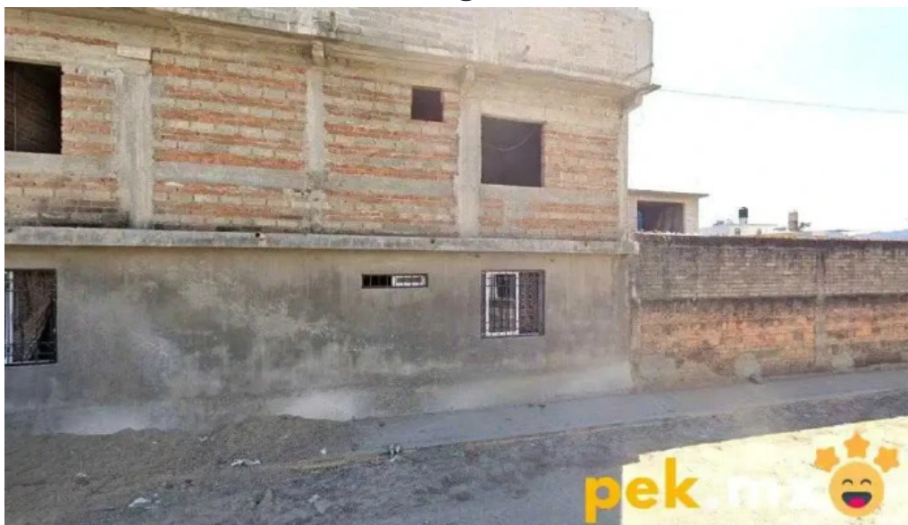
Comision federal de electricidad putla putla villa de guerrero
