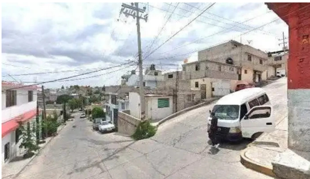
Instalaciones electricas lozano cerca de mideg
