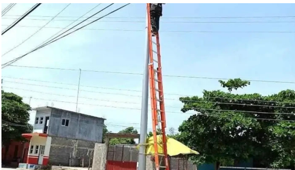
Hernandez automatizaciones oaxaca
