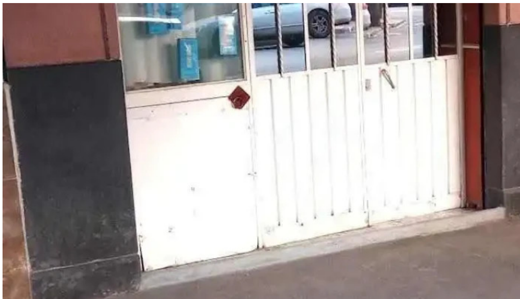
Instalaciones electricas de interfonos y mantenimiento general azcapotzalco ciudad de mexico
