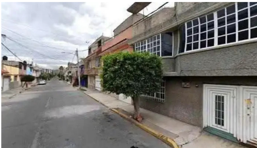
Sistemas electricos y de comunicacion direcciondeg
