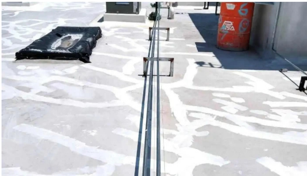
Cmt instalaciones electricas del propietario
