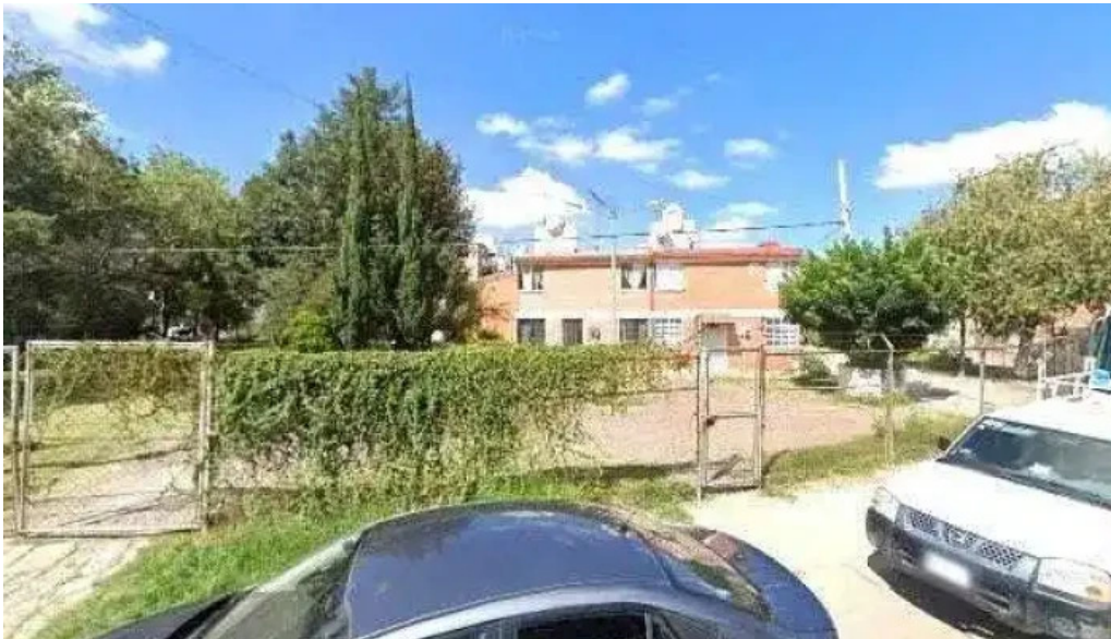
Cmt instalaciones electricas promociondeg
