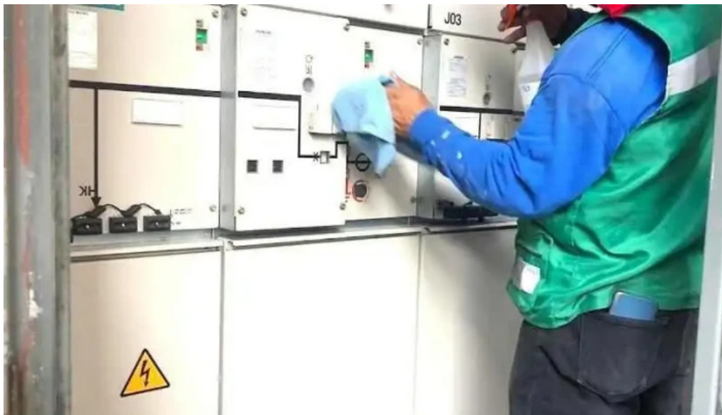
Telesma sistemas electricos s a de c v cuautitlan izcalli
