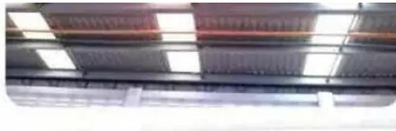
**Trabajo de canalización de tubería galvanizada fijado en unicanal con soporte de varilla roscada.**
