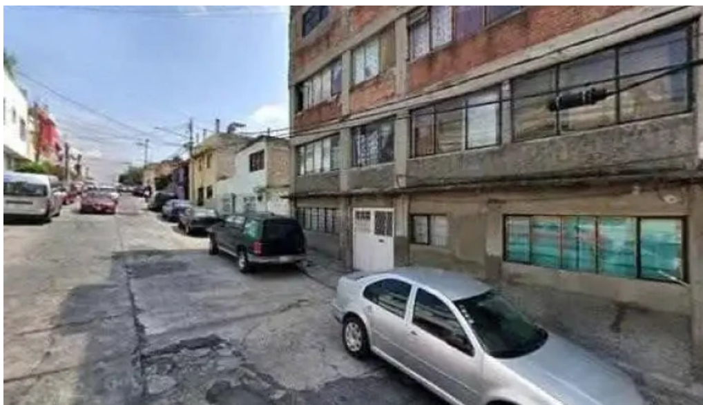
Instalaciones electricas residenciales cerca de mideg
