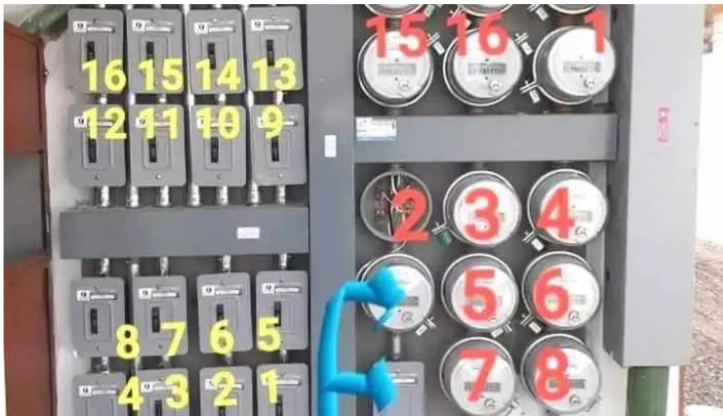
Electricista y fontanero instalaciones ortiz del propietario
